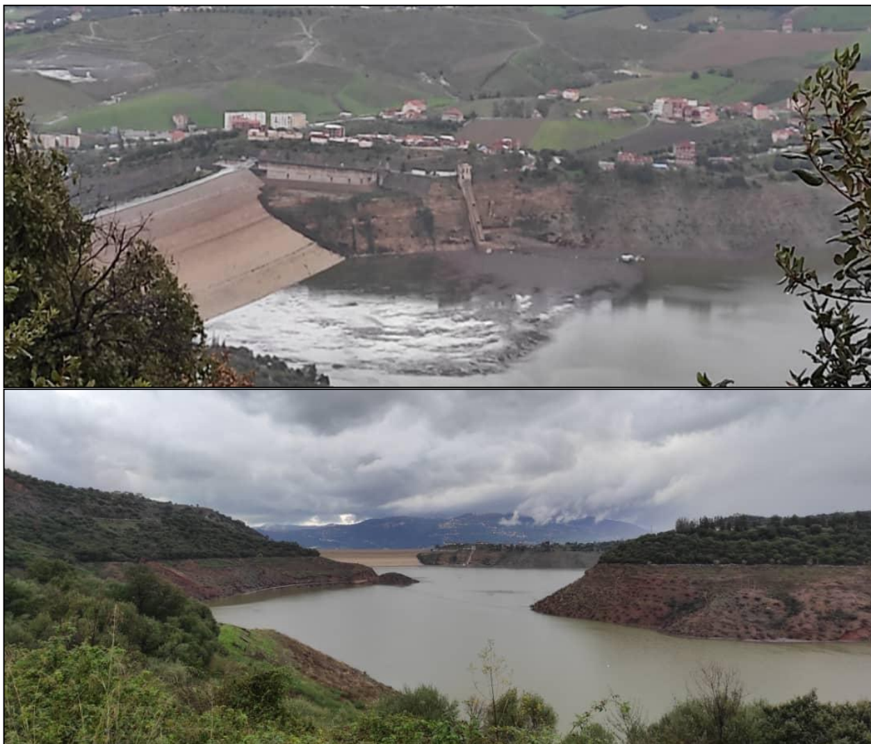
Figure I.17: vue du barrage taksebt (novembre 2021).
