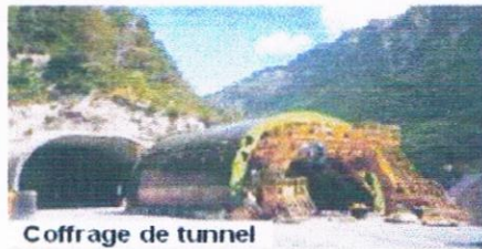
Coffrage de tunnel
