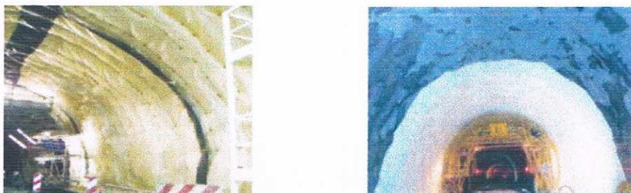
Fig.I.16. Etanchéité d'un tunnel.
