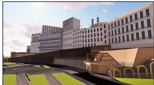
Figure 74: Vue du port sur la place Lumumba et la mosquée Sidi Mouhoub
