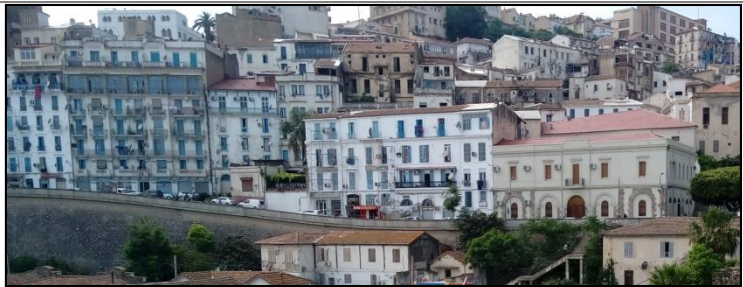
Figure 29: Image sur les travaux de la façade maritime ( prise de la gare maritime par auteurs)
