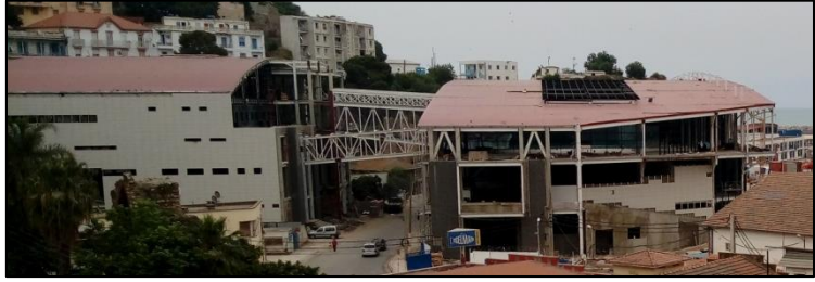
Figure 31: La nouvelle gare maritime en cours de réalisation (Prise par auteurs)
