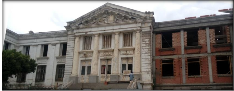
Figure 32: Tribunal de Béjaïa en cours de reconstruction (Image prise par auteurs)
