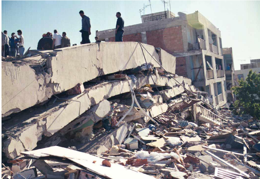
Figure1. 1 Effondrement d'un immeuble de quatre étages (Pancake-collapse). Suite au séisme de Boumerdes 2003. [2]
