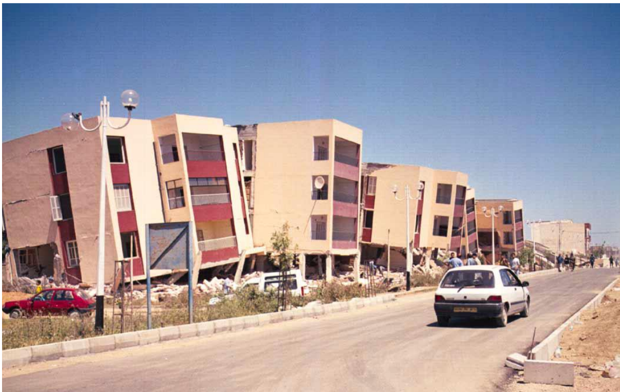
Figure 2.12 Effondrement complet du rez-de-chaussée (étage souple) dans plusieurs blocs résidentiels à Corso. Séisme de Boumerdes 2003, Algérie. [2]
