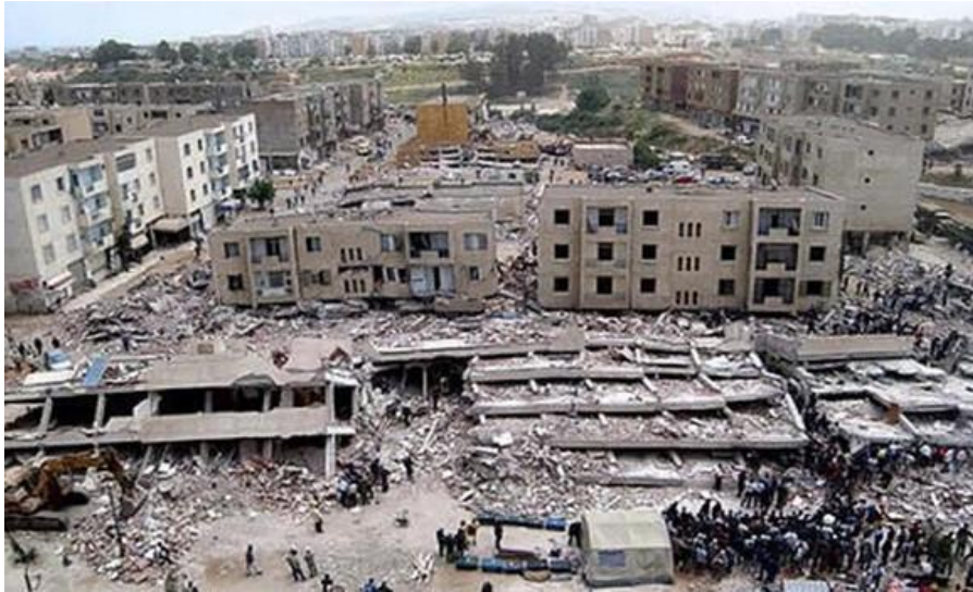
Figure 1. 12 Dégâts importants causés par le séisme de Boumerdes en 2003 [26]
