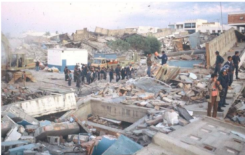
Figure1. 11 Dommages causés par le séisme de Chlef (ex-El Asnam) en 1980. [25]
