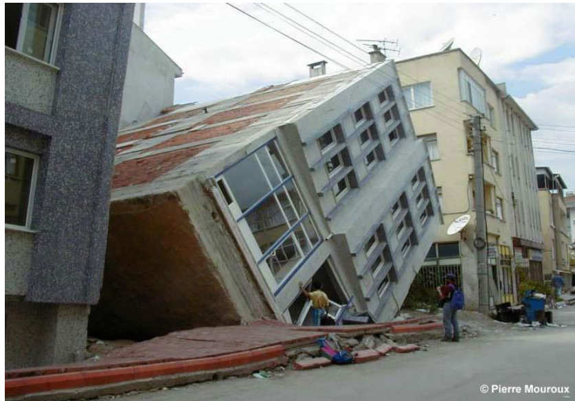
Figure 2.14 Dommages dus à la liquéfaction des sols : Effondrement d'un immeuble par affaissement du sol lors du séisme d'Izmir (Turquie) en 1999. [61]
