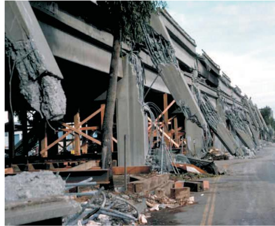
Figure 2. 8 Effondrement du Viaduc Cypress Street à Oakland, ( séisme de Loma Prieta « Californie, 1989 »). [54]
