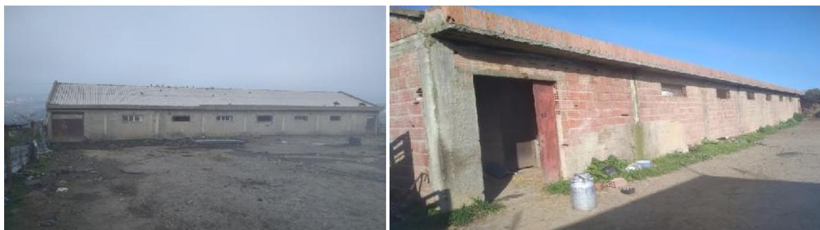
**Figure 31** : bâtiments d'élevages de type hangars simple en béton.
