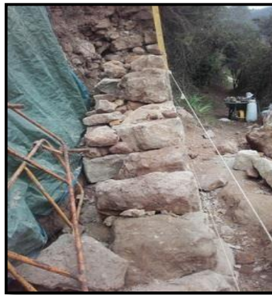
Figure 63 : Mur de soutènement en pierre.
