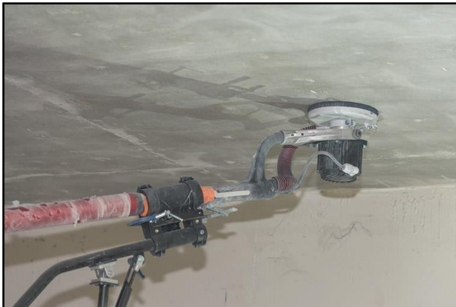
Figure 77 : Préparation du support à renforcer, ponçage.
