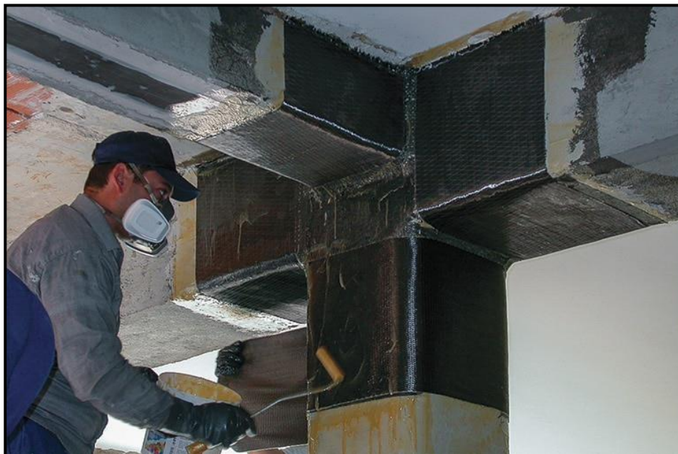
Figure 73 : Collage de tissu carbone au niveau de la jonction entre deux poutres et un poteau.
