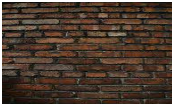
Figure I.1: Mur en maçonnerie
