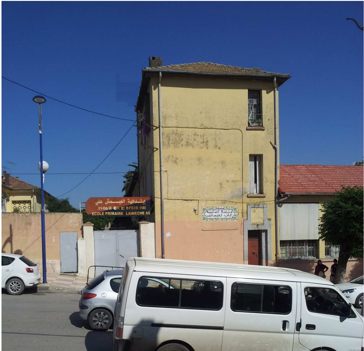
Figure III.1 : Vue de la structure analysée.
