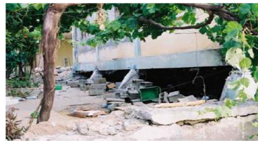
Figure I-8 : Poteaux courts dus au vide sanitaire [2].
