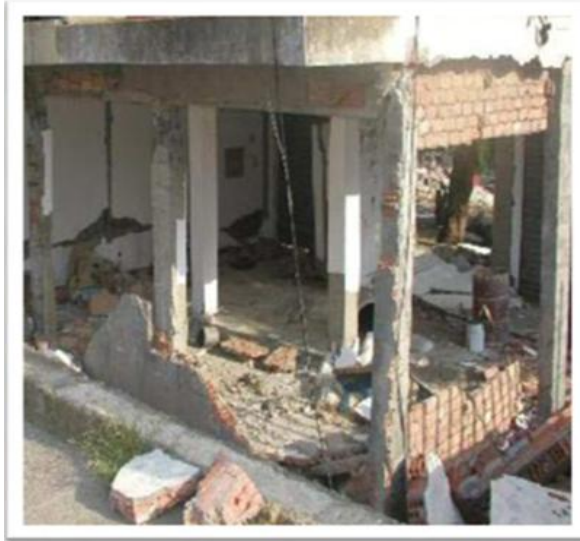
Figure I-5 : Plastification due à la flexion des nœuds [2].
