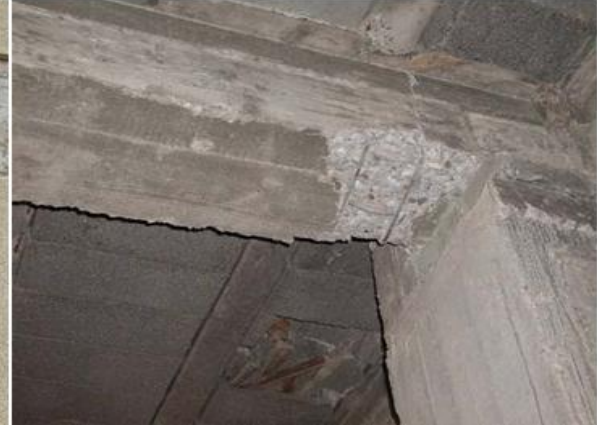
Figure I-16 Rotule dans la poutre (comportement recherché) [1]
