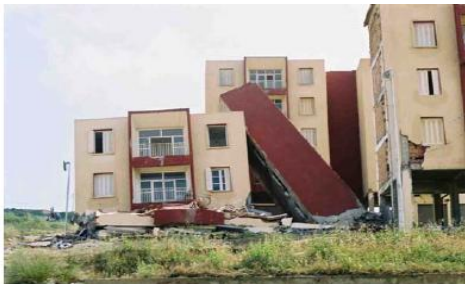
Figure I-7 : Structures présentant des étages transparents (RDC) [2].
