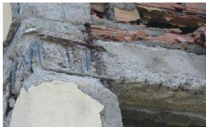
Figure I-10 : les cadres sont absents au cœur du nœud [2].
