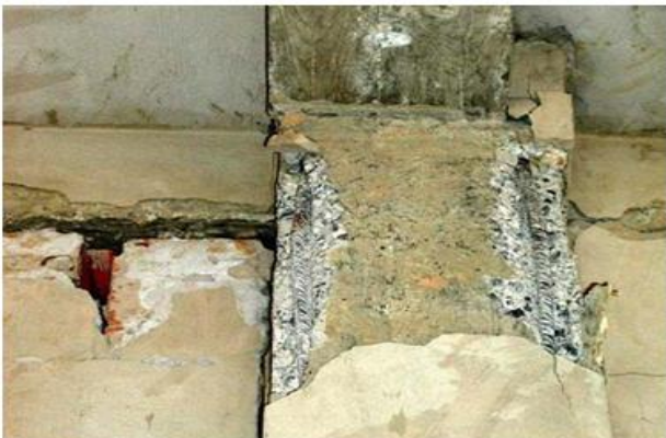
Figure I-17 Flambement d'armatures longitudinales [1]
