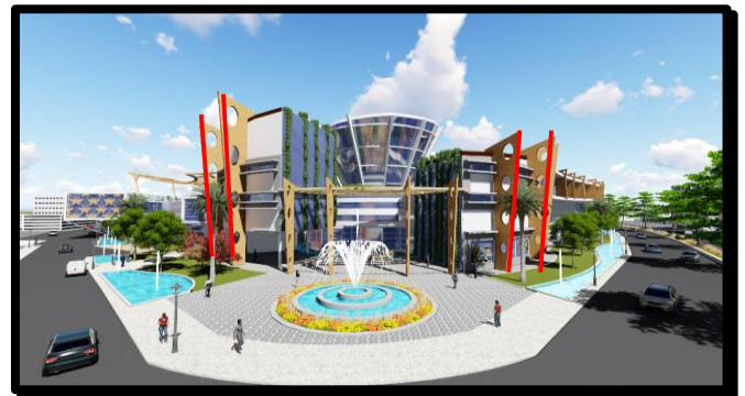
Figure 157: des avancés verticaux. Source : auteurs
