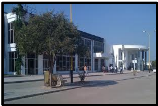
Figure 42: aéroport international. Source : mémoire m2 architecture.
