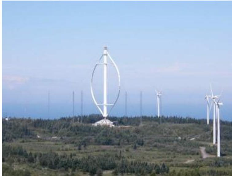
**Figure I.7 :** Eolienne de type Darrieus.
