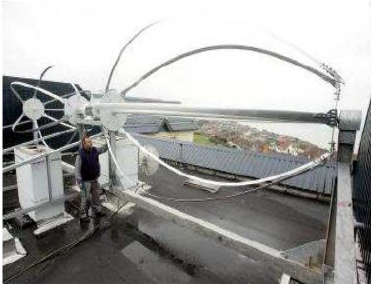
**Figure I.5 :** Aérogénérateur à axe horizontal de type Darrieus.
