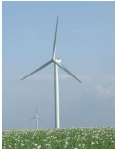
**Figure I.3:** Eolienne à axe horizontal.
