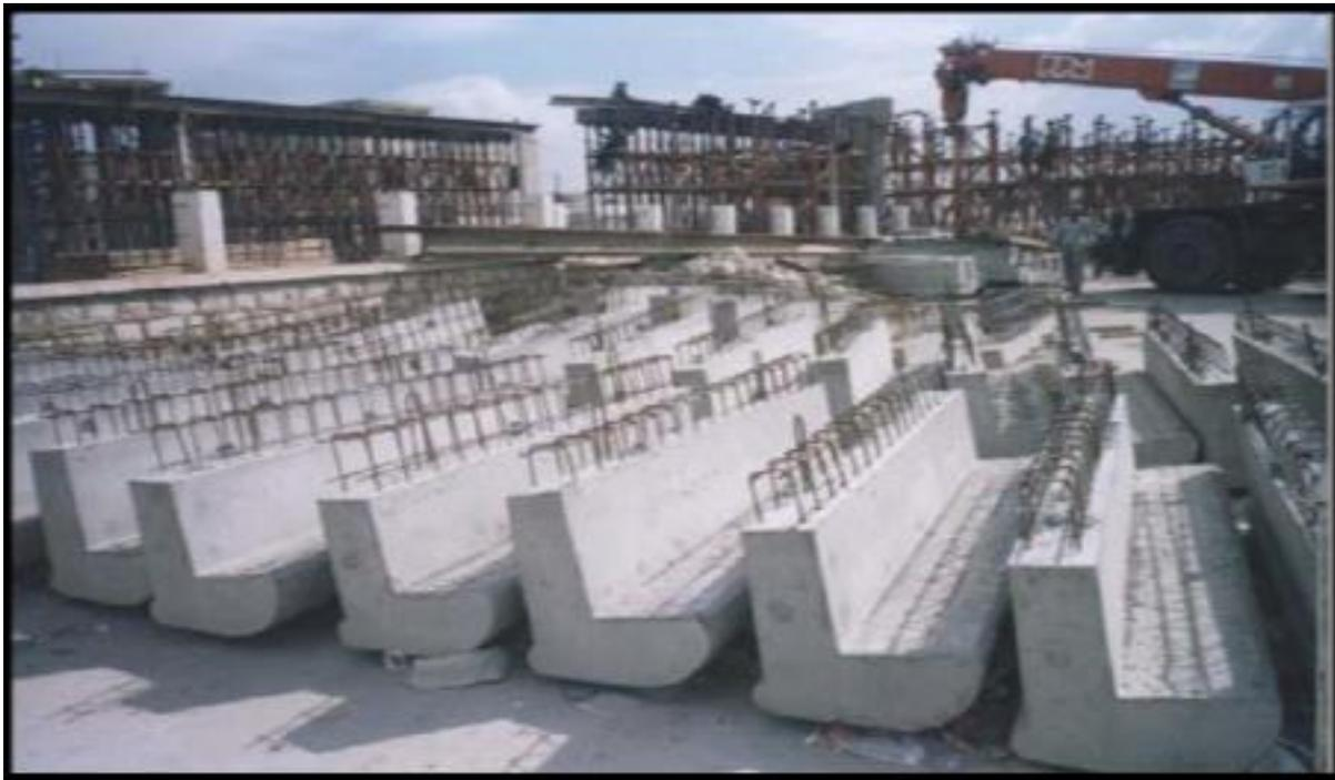
Figure X.4: Corniches préfabriquées sur chantier.
