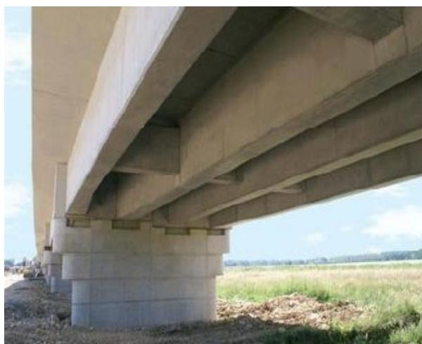
Fig.III.2 : Pont à poutre multiple en béton précontraint
