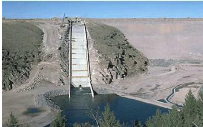
Figure II-9 : Vue sur le barrage de Téton (USA) avant rupture
