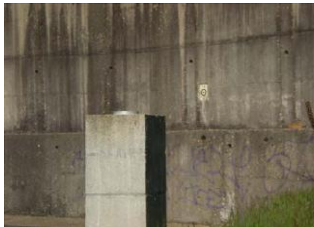
Figure IV-11: Support et cocarde de visée pour alidade
