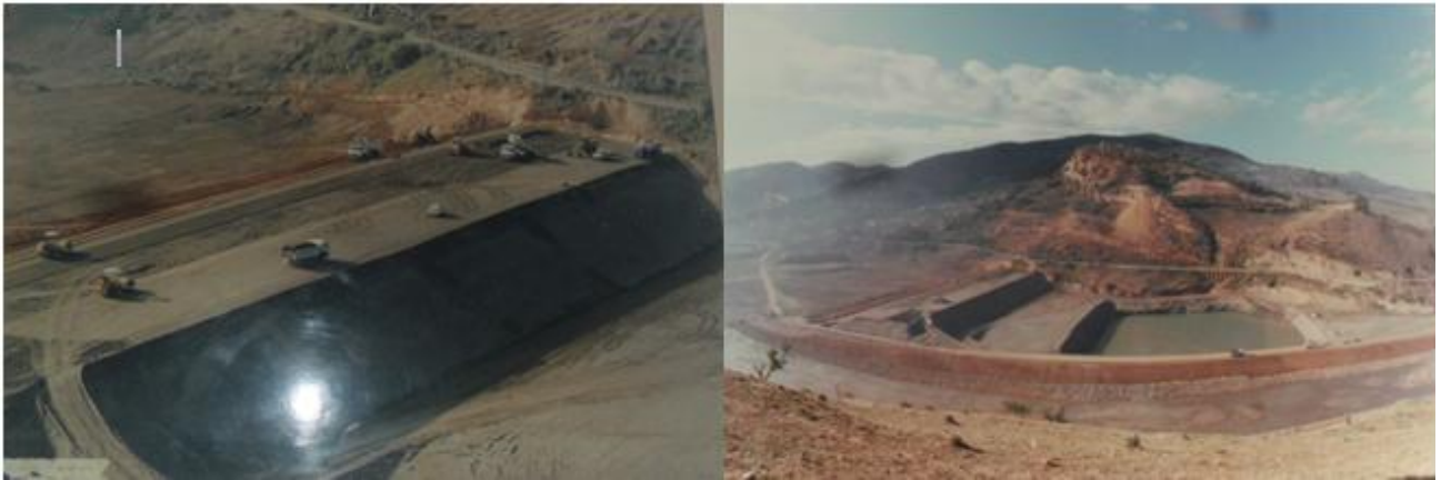
Figure VI-1: Construction du barrage de Taksebt
