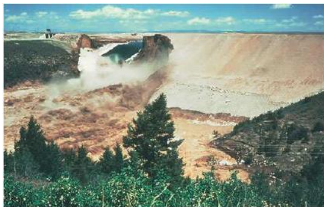
Figure II-10 : Rupture du barrage de Téton (USA).
