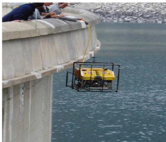
Figure III-6 : Visite décennale du barrage de Cap de Long – descente du robot subaquatique (juin 2006)
