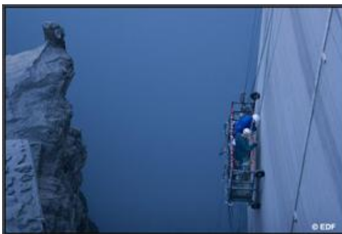
Figure III-4 : Inspection des ouvrages lors de sa vidange
