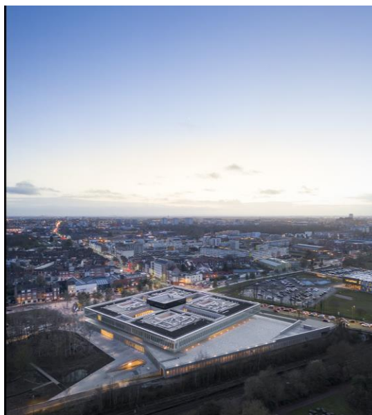
Figure 12 : Vue du Projet à partir de la voie ferroviaire. Source : Archdaily.
