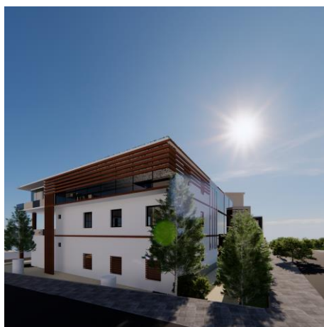
Figure 15 : Vue sud sur les brises solaires horizontaux. Sources : Auteurs.
