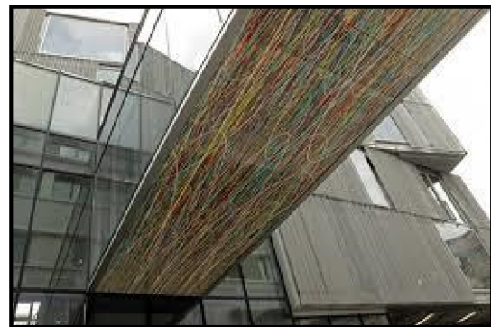
Photo III-28: Vue sur la passerelle
