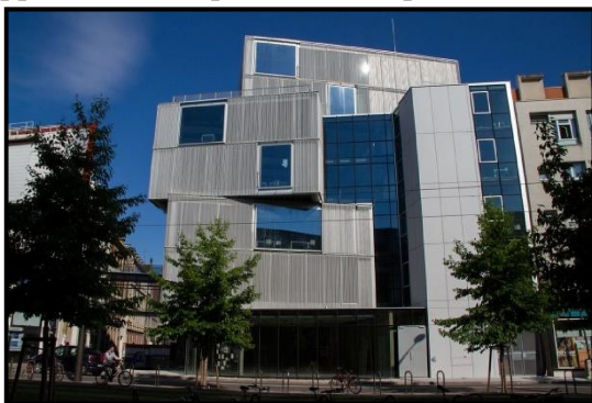
Photo III-27: Vue sur la fabrique Source:www.lemonde.fr
