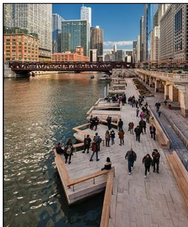
Photo IV-34: Aménagement des quais.
