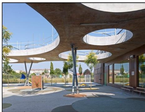
Photo IV-36: Couverture du jardin Source : Pinterest
