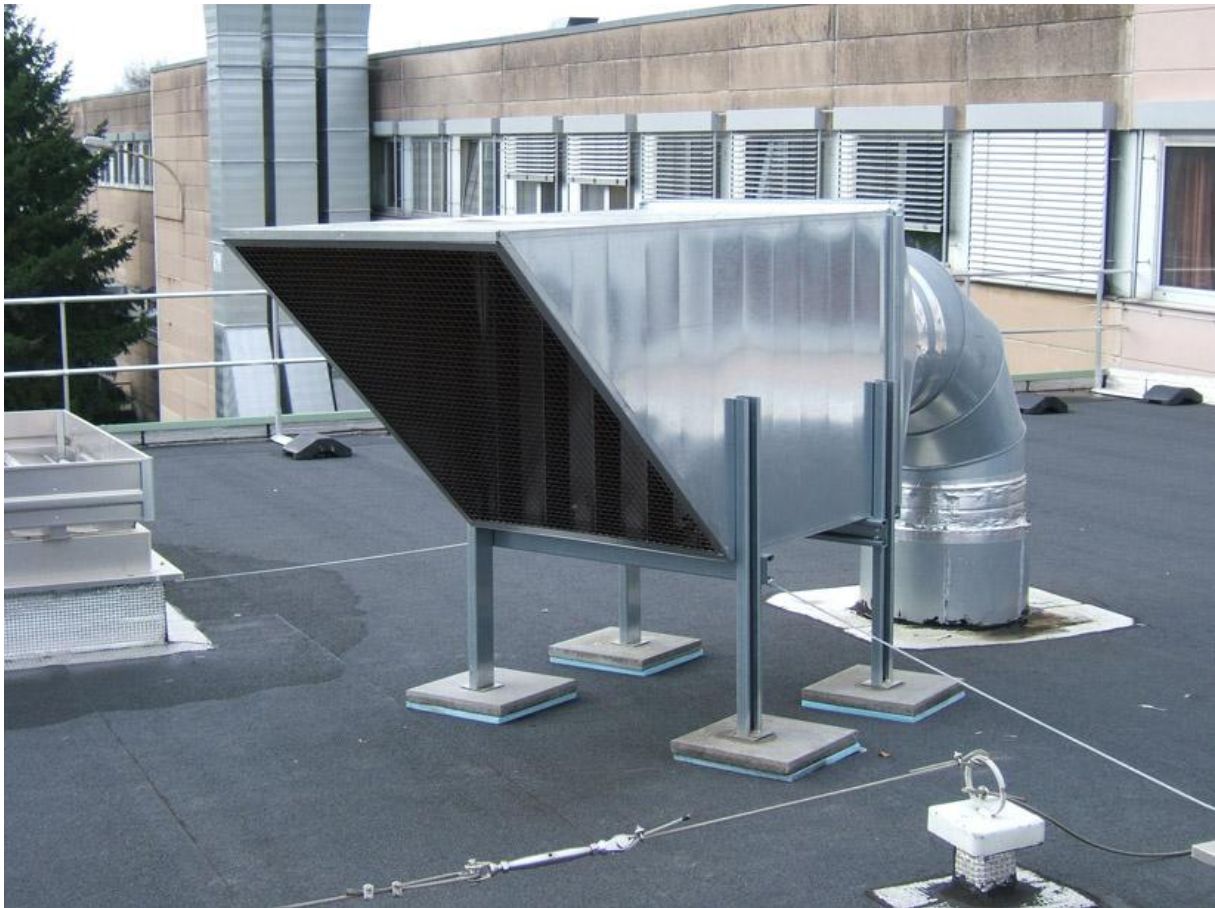
Figure I.8 : Piège à son installé sur le toit d'un immeuble
