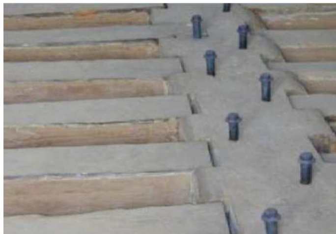
Figure 1 .11 : Connecteur SBB
