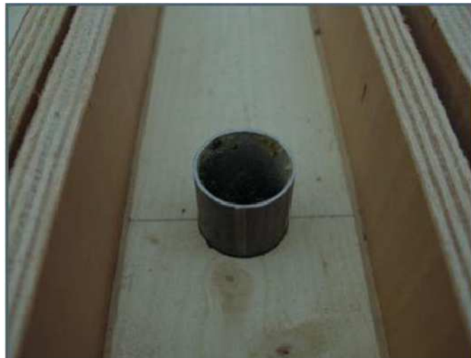
Figure 1 .9 : Connecteur tube
