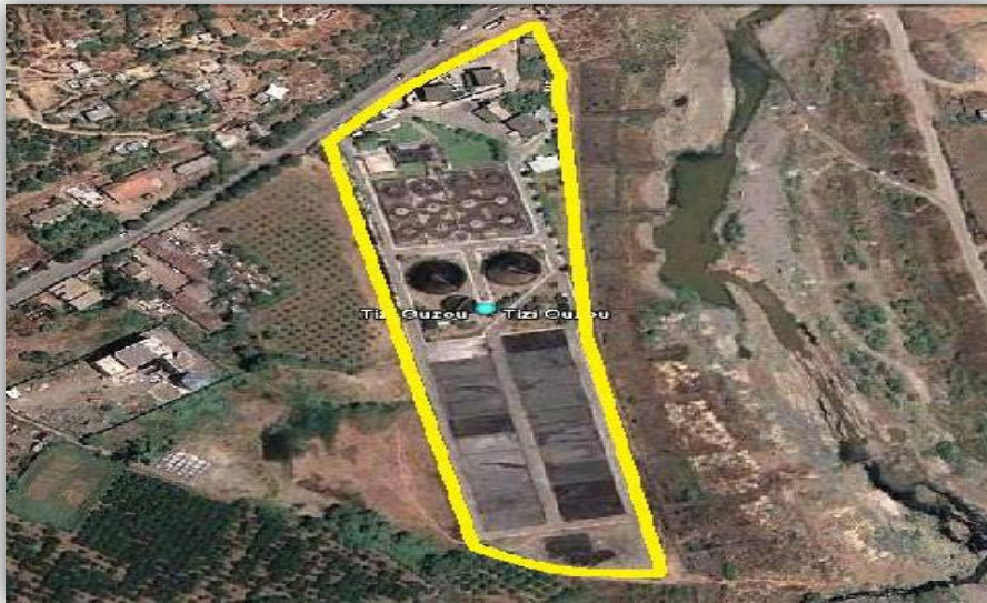
Figure II.1 : Vue générale de la station d'épuration du pont de Bougie
