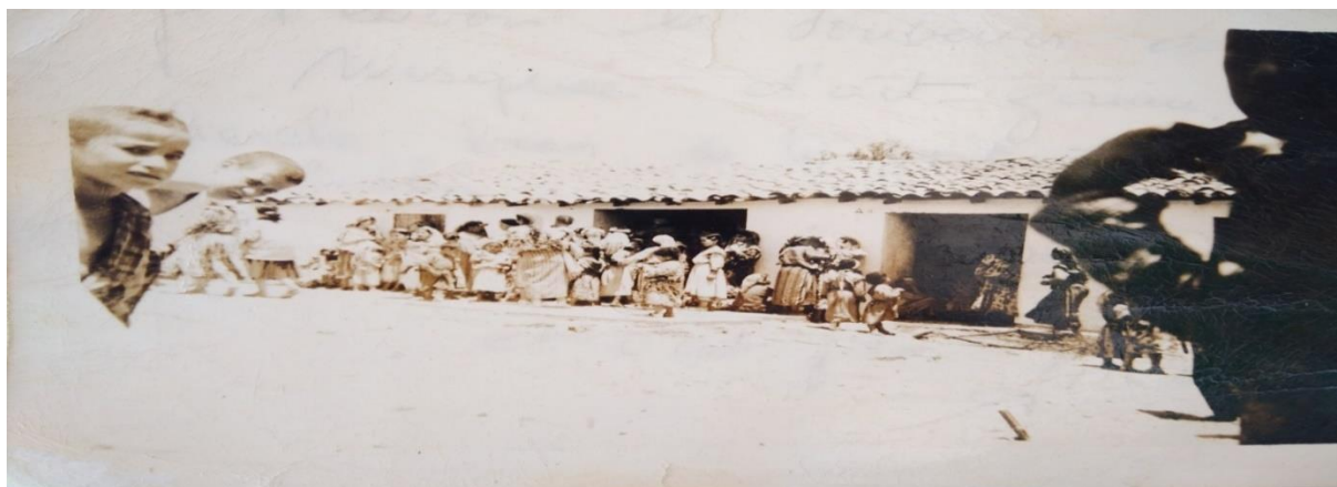
Photo : La mosquée sidi M'Hamed Amghit les années 1960
