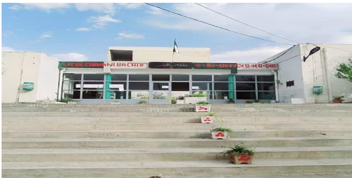
Vue extérieure de l'entrée du lycée chihani bachir, durant l'année 2025.
