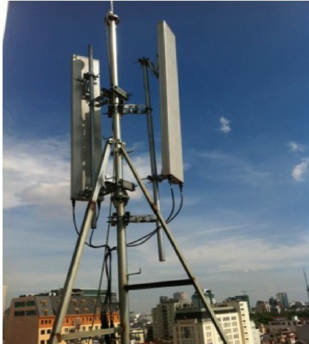
**Figure 1.5 :** Photo d'une BTS
