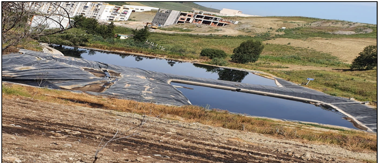
Figure2 : bassins de stockage des lixiviats de la décharge d'Oued Falli de Tizi Ouzou.
