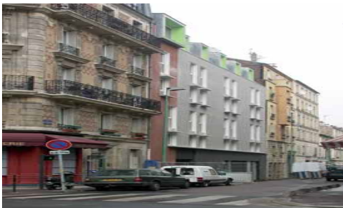
Figure 40 : Résidence sociale 68 logements.
