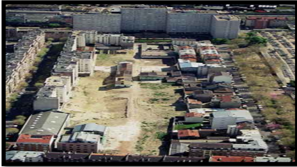
Figure 46 : la création d'un parc sur les terrains Bic
