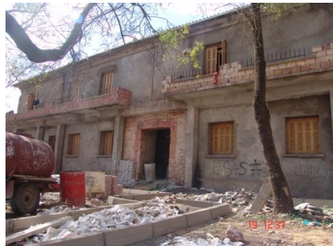
Figure38: les travaux de revêtement des façades source : image prise par Mr Bourihane
