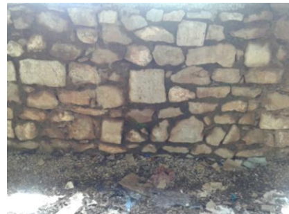
Figure 5 : l'appareillage des murs de sanatorium source: image prise par l'auteur
