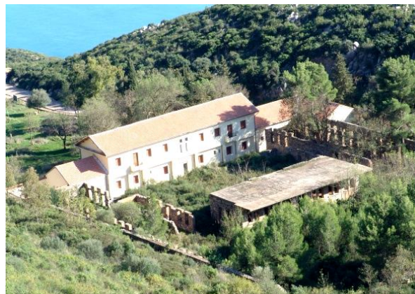
Figure 7: : le site après le projet de réhabilitation source : http://google.img
