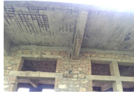
Figure 32 : la dalle du sanatorium source : image prise par l'auteur
