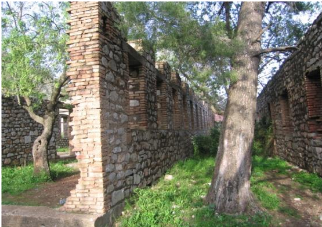
Figure 45: les arbres forment des allées à l'intérieur des blocs ou les cloisons intérieures sont disparues
