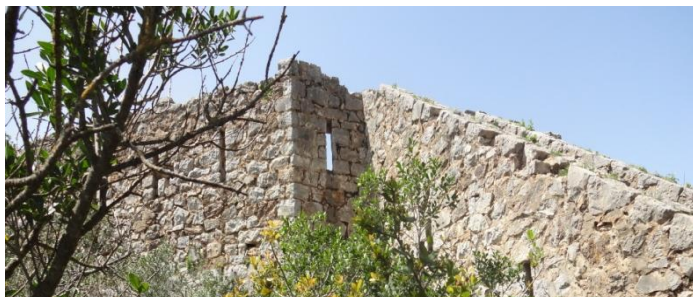
Figure 26 : image prise de l'extérieur du poste de garde
