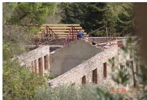
Figure8 : image prise lors de la mise en œuvre de la charpente
