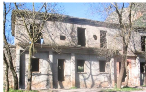
Figure 35: structure extérieur rajoutée
