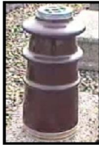
**Fig. I.4:** Photo isolateur support
