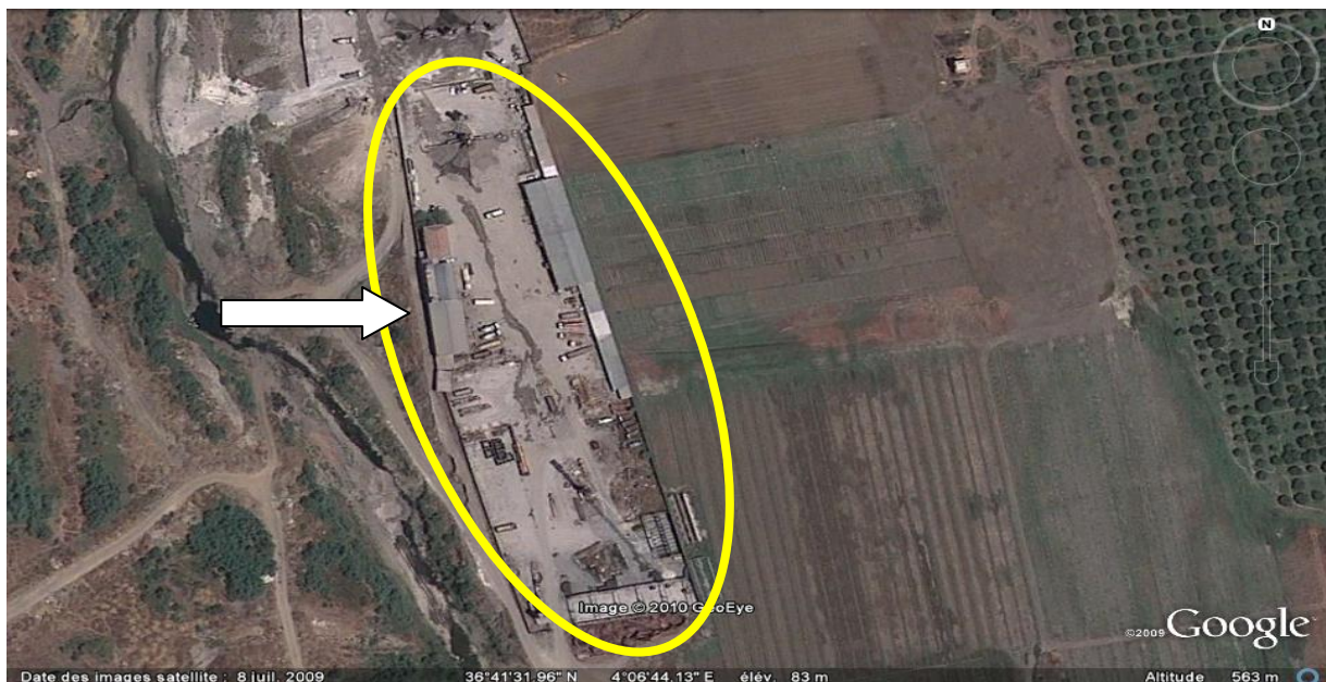
Centrale à béton d'Oued Aissi (versant ouest de la ville de Tizi Ouzou)
