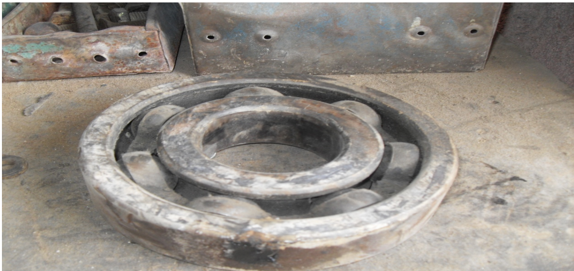
Roulement de la sablière à l'origine du blocage
