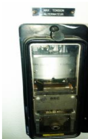
Fig.IV.3 : Relais de protection à Maximum de tension
