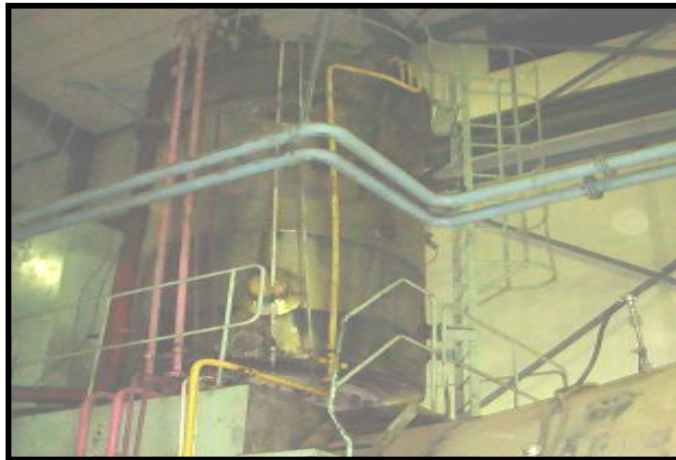
Fig. I.5 Chambre de combustion
