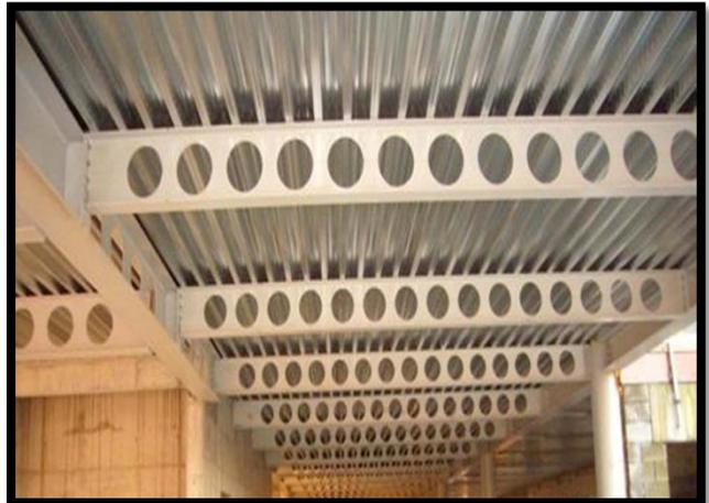
Figure 100 : Plancher collaborant sur poutres alvéolaires.
