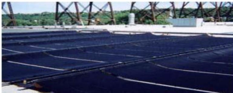
Figure II.2: Capteurs plans sans vitrage [15]
