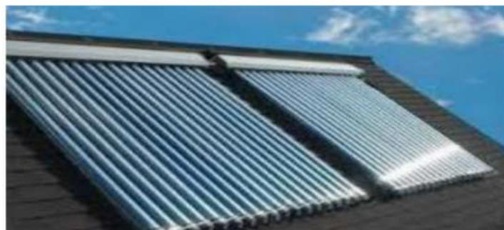
**Figure II.4:** Capteur sous vide [15].
