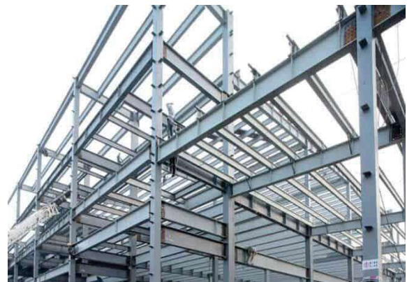
Figure V.14: structure à ossatures Métalliques
