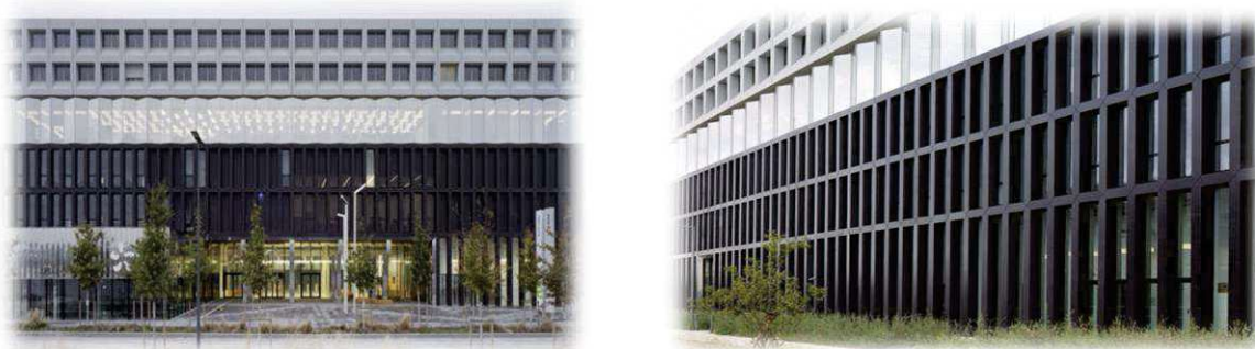
Figure II 34 : Les façades extérieures de campus EDF de Saclay.
