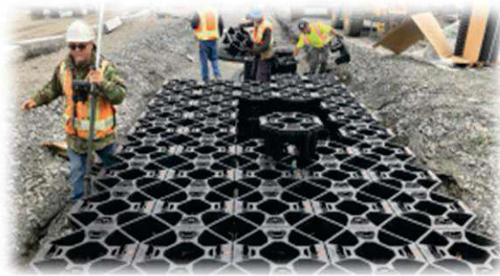
Figure II 21 : Mise en place des cellules d'enracinement ; Figure II 22 : Fosses d'arbres de l'avenue Outremont. Pour les fosses d'arbres continues de l'avenue Thérèse-Lavoie-Roux.
