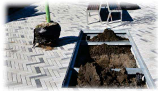
Figure II 21 : Mise en place des cellules d'enracinement ; Figure II 22 : Fosses d'arbres de l'avenue Outremont. Pour les fosses d'arbres continues de l'avenue Thérèse-Lavoie-Roux.
