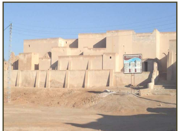
Photo 4 : Réhabilitation du ksar Tamarna Lakdima en utilisant un enduit à base de ciment. (Source : Auteur).
