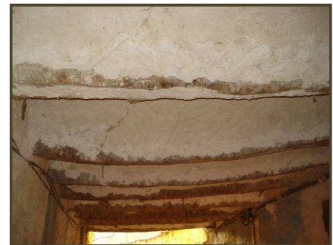
Photo II.31 : Plancher relié au mortier de Timchent, Ksar Ghardaia (Source : Auteur)
