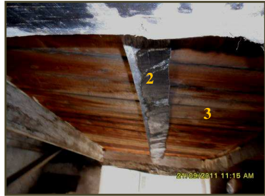
Photo II.13 : Plancher à rondins de bois naturel, Beni Yenni (Source Auteur).
