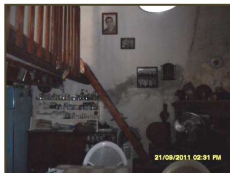
Photo II.28 : L'échelle remplace l'escalier, Beni Yenni (Source : Auteur).
