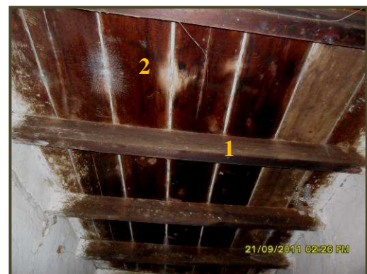
Photo II.14 : Plancher à solive usiné, Beni Yenni (Source : Auteur).
