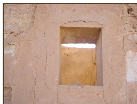
Photo III.18 : Formation de l'arc de décharg, Tamarna Lakdima (Source : Auteur).
