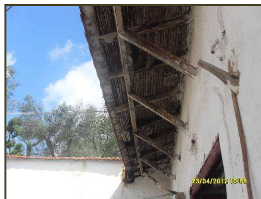
Photo IV.8 : Protection du haut du mur par une toiture débordante, Maatkas (Source : Auteur)
