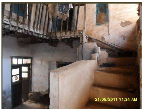
Photo II.27 : Escalier intérieur en pierre, Beni Yenni (Source : Auteur).
