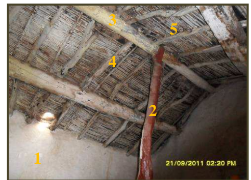
Photo II.21 : Couverture traditionnel à double pente, Beni-Yenni. (Source : Auteur).
