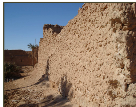
Photo III.13 : Formation de ventre à la base du mur, Tamarna Lakdima (Source : Auteur).
