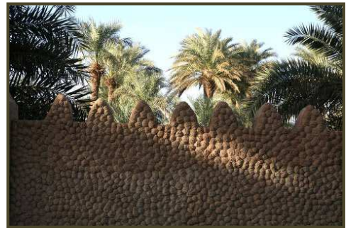
Photo II.34 : Traitement de surface, Timimoun.
