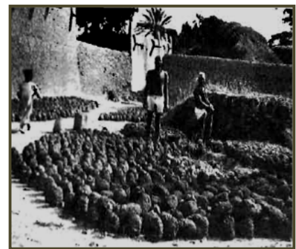
Photo II.8 : Une fabrique des briques de terre au Nigeria (Source : CRATerre).
