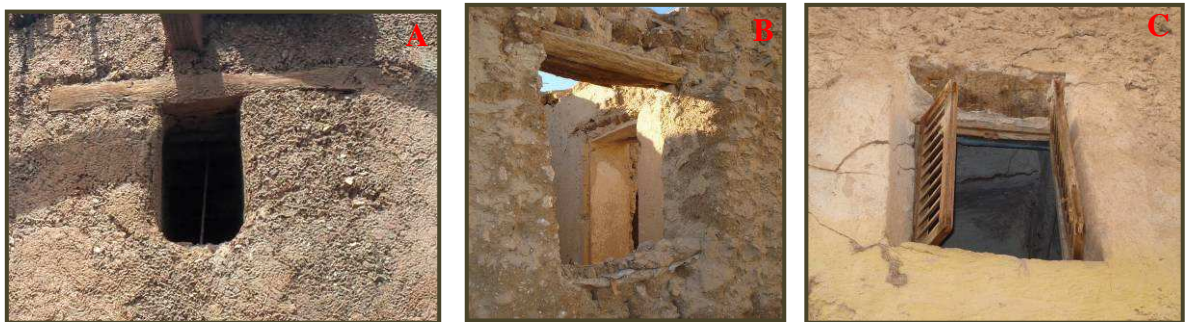
Photos II.20 : Fenêtres et linteaux. A : Maatkas, B : Ksar Témacine, C : Ksar Ghardaia (Source : Auteur).
