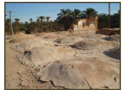
Photo II.39 : Couverture en coupole surbaissée, Témacine. (Source : Auteur).
