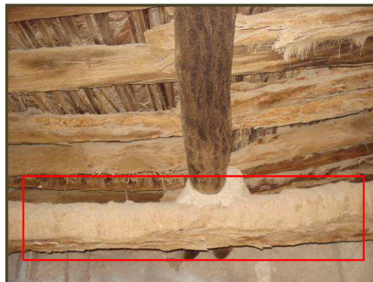
Photo IV.4 : Ajout d'un montant en bois, Témacine (Source : Auteur).
