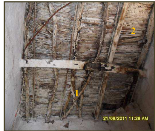
Photo II.12 : Plancher traditionnel, Beni Yenni. (Source : Auteur).
