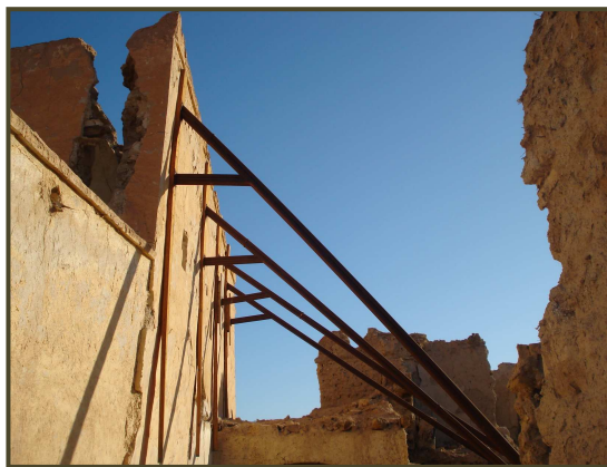
Photo III.12 : Etalement du mur déversé vers l'extérieur, Témacine (Source : Auteur).
