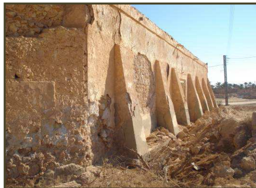
Photo IV.2 : Contrefort, Ksar Témacine (Source : Auteur)
