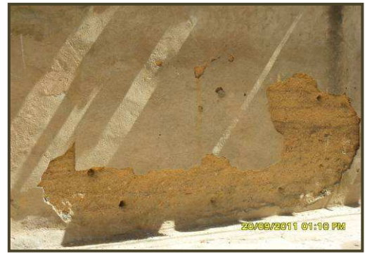
Photo II.35 : Maison en terre enduite au ciment, Maatkas (Source : Auteur).
