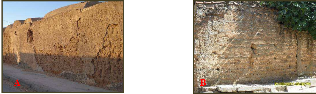
Photo II.11 : Mur de terre posé directement sur le sol (A : El-Oued, B : Beni-Yenni). (Source : Auteur).
