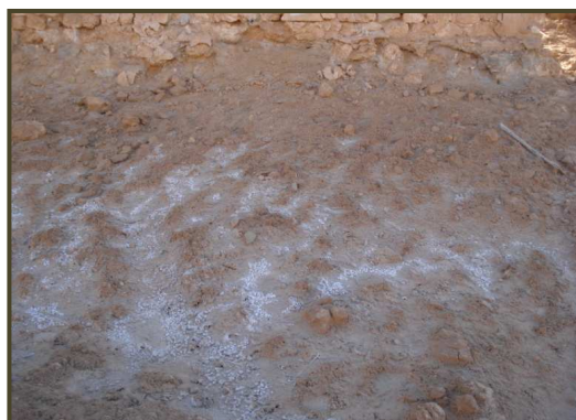
Photo III.6 : Formation de cristaux de sel à la surface du terrain à joutant le mur de terre, Tamarna Lakdima (Source : Auteur).
