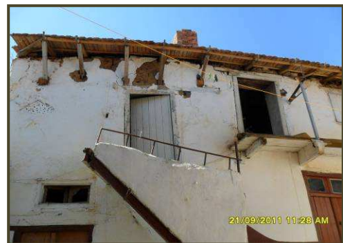
Photo II.30 : Maison en pisé enduite à la chaux, Beni Yenni (Source : Auteur)
