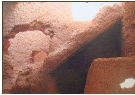
Photo II.24 : Escalier sur paillasse en bois. (Source : Ait Kadi.S, 2012)
