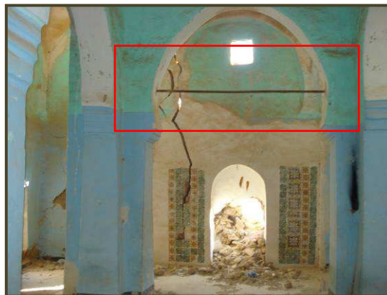
Photo IV.6 : Consolidation de la voûte par un tirant métallique, Témacine (Source : Auteur)
