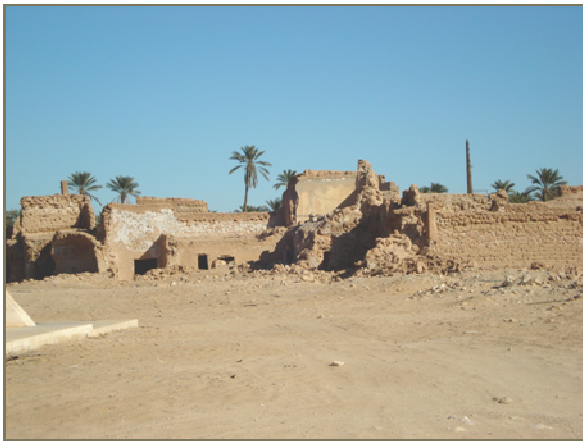
Photo 3 : Dégradation du Ksar de Témacine. (Source : Auteur)
