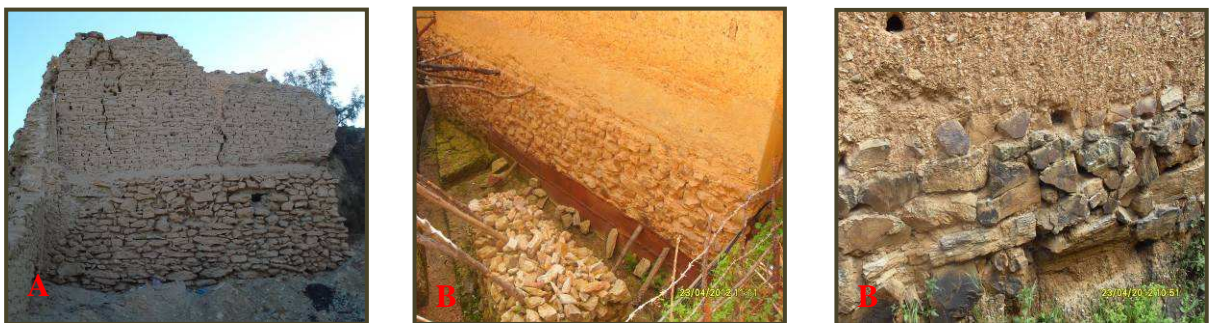
Photos II.10 : Mur de terre posé sur un soubassement de pierre. (A : Ksar Témacine, B : Maatkas). (Source : Auteur).
