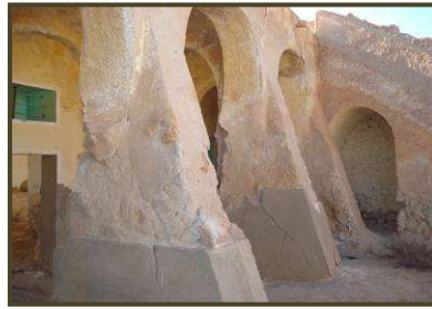
Photo II.17 : Piliers servant de support pour l'arcature de l'étage, Ksar Témacine. (Source : Auteur).
