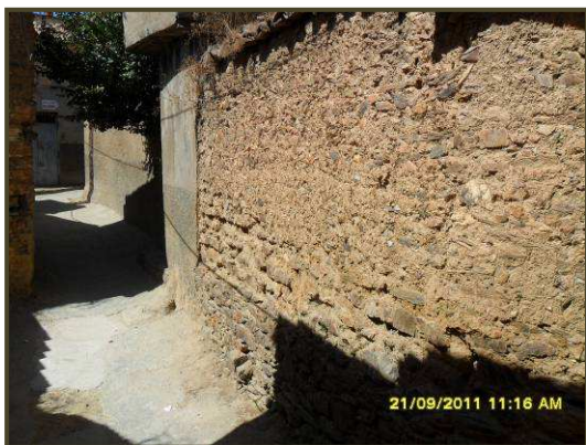
Photo IV.7 : Protection d'un mur en pisé par un soubassement de pierre, Beni Yenni (Source : Auteur)
