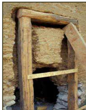
Photo IV.5: Percement d'une porte dans un mur en pisé. (Source : Moriset S)
