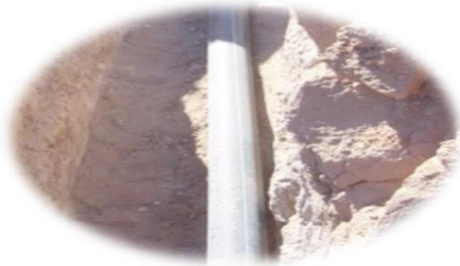
Fig V -1. Pose des conduites en terre.
