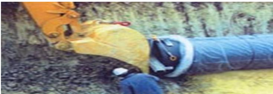
Fig V-6. Pose de conduites dans un terrain agressif.
