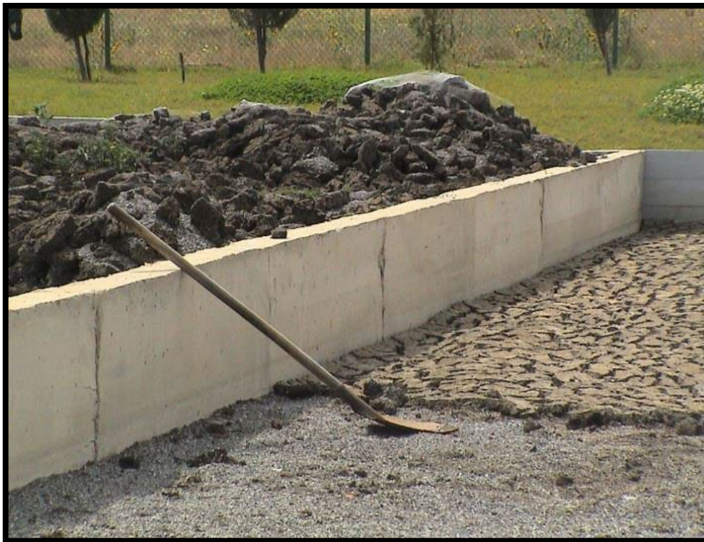
Figure III.6 Lit de séchage des boues
