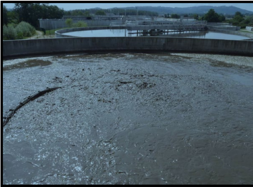
Figure III.1 : traitement par boue activée
