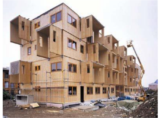
Figure 95: construction en bois massif
