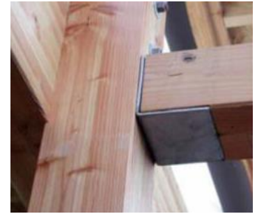
Figure 1: Détails d'assemblage poteau poutre
