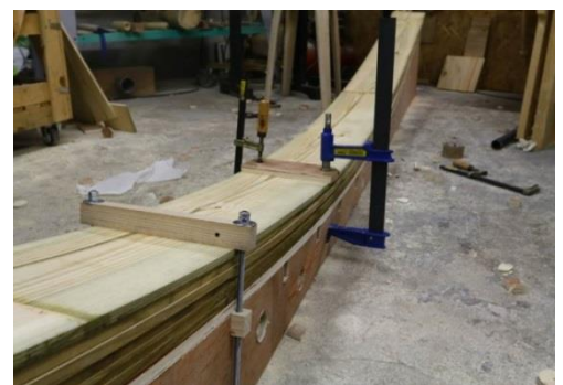
Figure 94: Réalisation d'une poutre en lamellé-collé source : tout-en-bois.com
