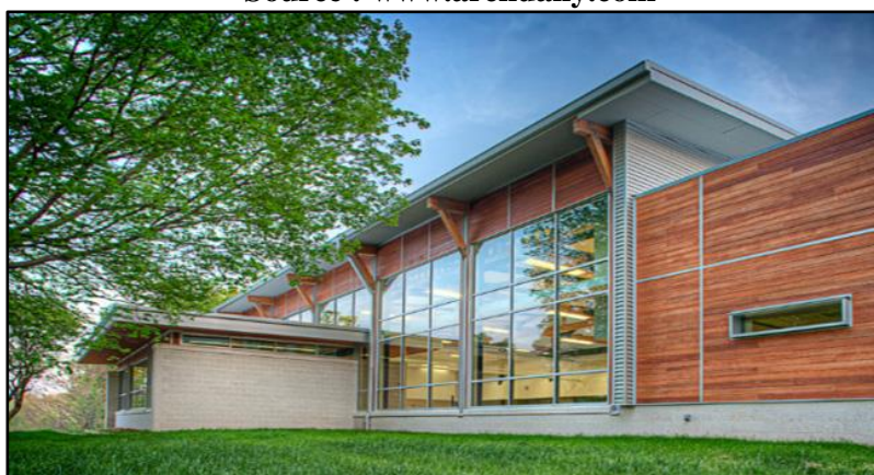
Figure 56:Façade postérieure de l'académie
