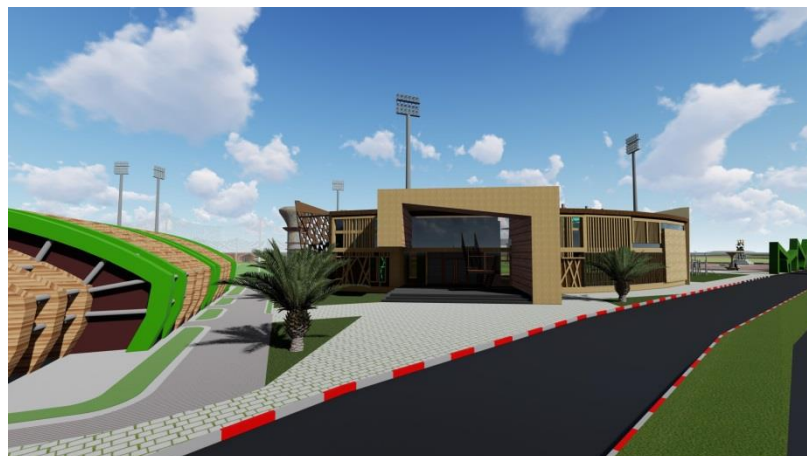
Figure 85:le bloc des soins source: auteur
