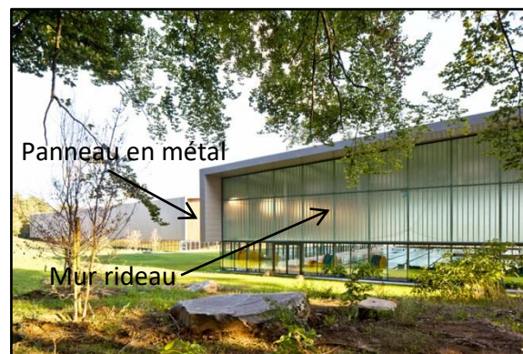
Figure 53: Les différents matériaux utilisés dans le bloc de la piscine
