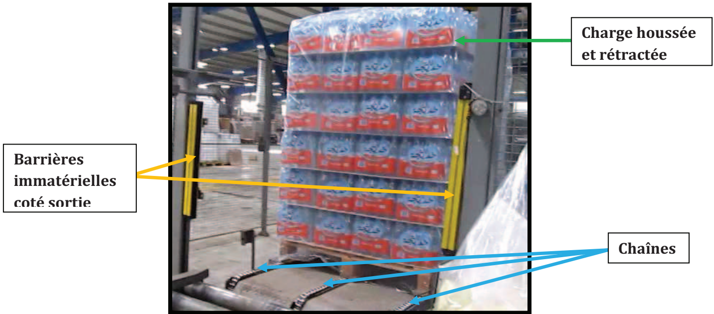
« Figure I-31 » : Montre le convoyeur de refroidissement C4.
