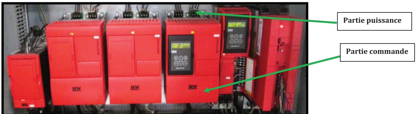
« Figure I.26 » : Présente les variateurs de vitesse SEW USOCOME.
