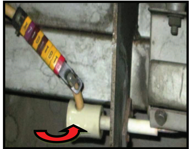
« Figure I-10 » : Présente les électrodes d'allumage.
