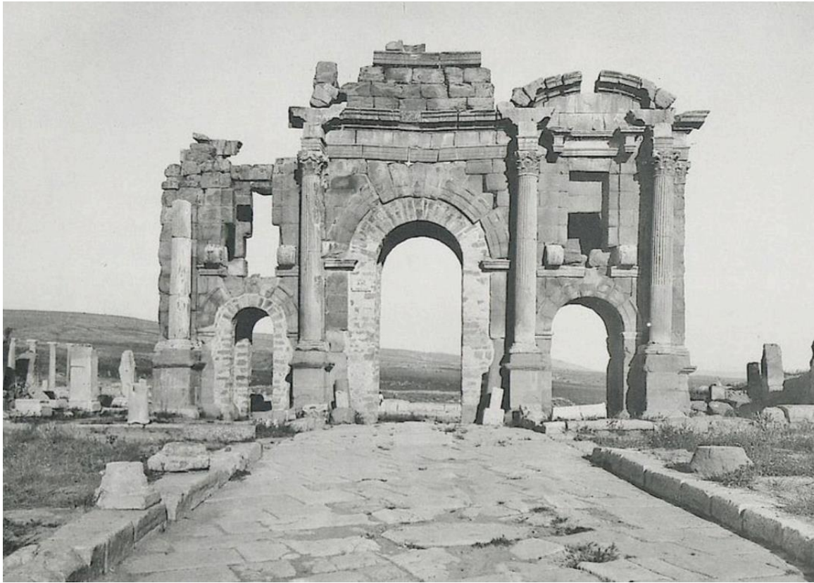
الصورة 12 : قوس تراجان (قبل الترميم)
