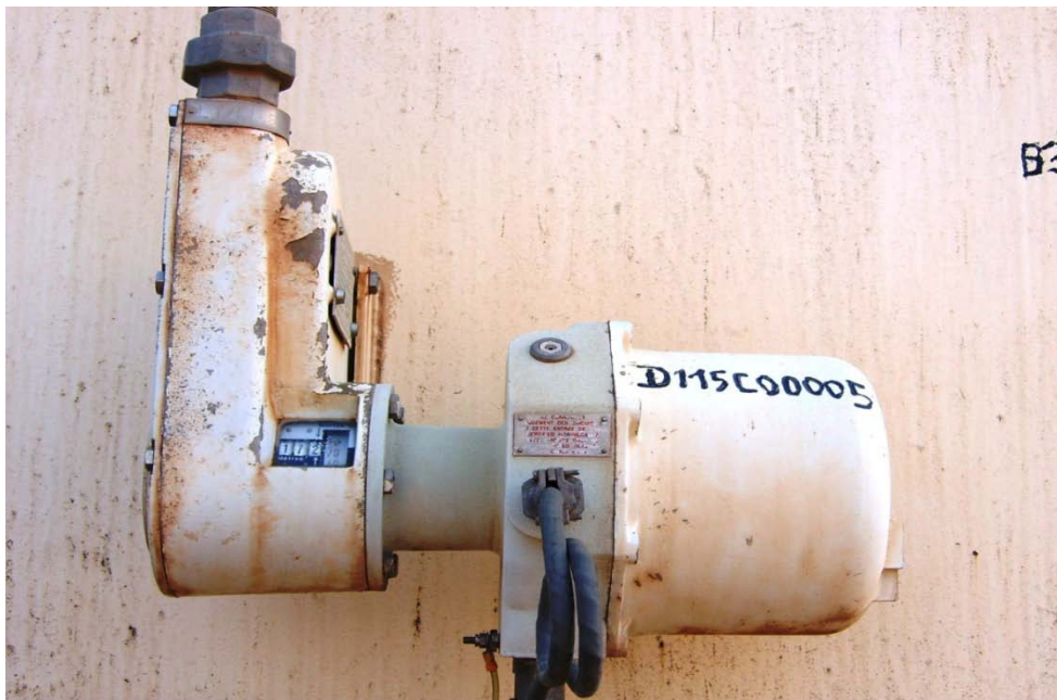
Figure 8 : Raccordement du transmetteur 1315 au jaugeur 2026 [5]
