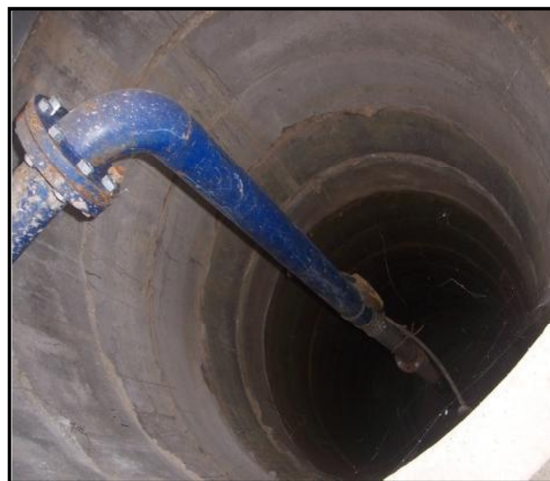
Figure II.2 : Forage F 6 équipé d'un GEP
