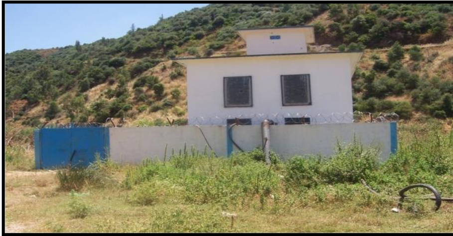
Figure II.3 : Abris du forage F 5
