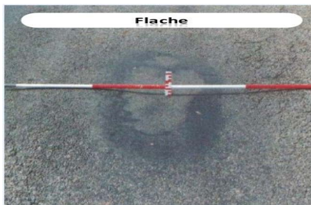
Figure I.13. flache (catalogues des chaussées)
