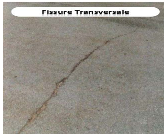
Figure I.16. fissure transversale (catalogues des chaussées)
