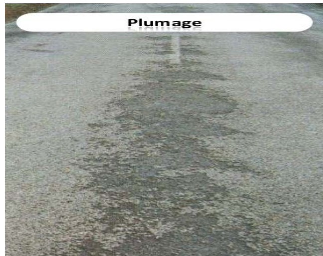
Figure I.20. Plumage (catalogues des chaussées)
