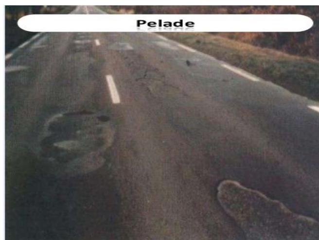
Figure I.19. Pelade (catalogues des chaussées)
