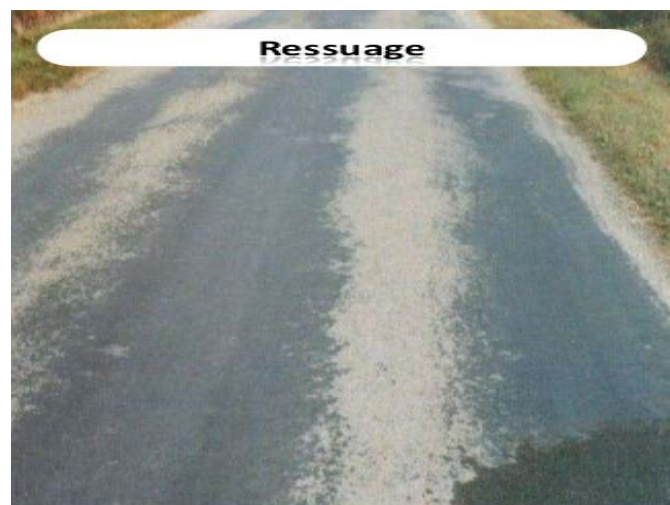
Figure I.21. ressuage (catalogues des chaussées)
