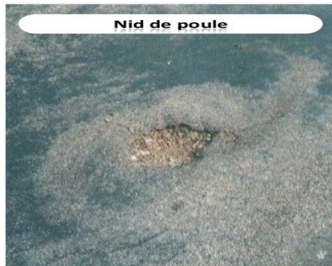
Figure I.18. Nid de poule (catalogues des chaussées)
