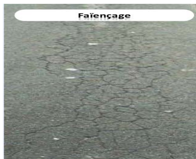
Figure I.17. Faiénçage (catalogues des chaussées)
