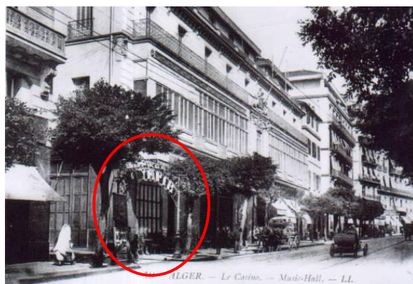
Fig. 4.6. Vue L'Olympia à partir de la rue d'Isly Source : http://alger-roi.fr
