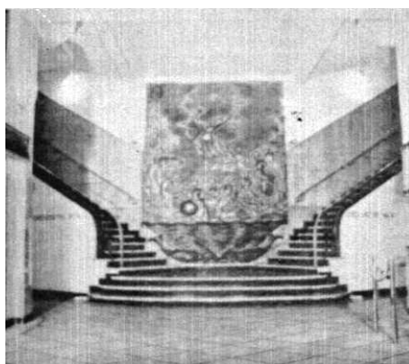
Fig. 4.33 : Versailles, vue sur l'escalier et la décoration du Hall
