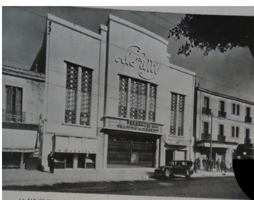
Le cinéma « Le Roxy » Source : Revue Chantiers, janvier 1939
