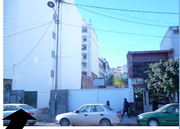
Démolition du cinéma Caméra Source : Auteur
