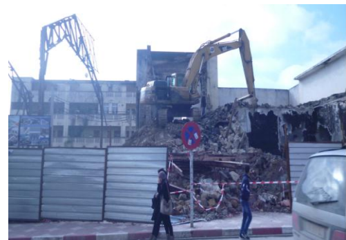
Fig. 3.9 : Démolition du cinéma Djurdjura de Tizi-Ouzou
