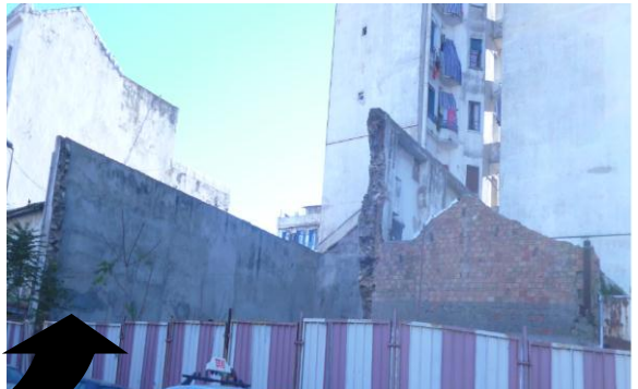
Ce qui reste du Musset (actuel Errazi) Source : Auteur
