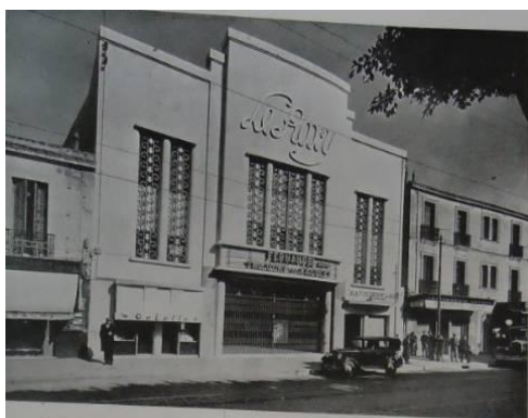
Fig. 4.30 : Le Roxy Source : Revue Chantiers, janvier 1939.
