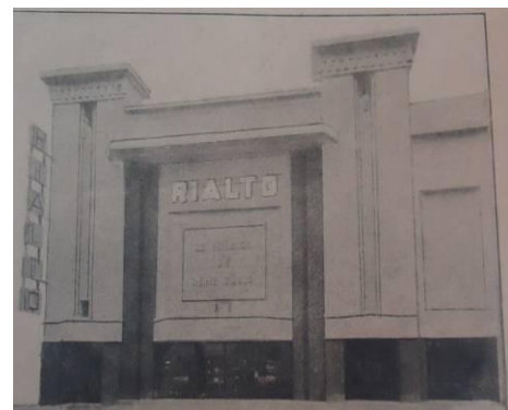
Fig. 3.2 : Façade du Rialto d'Oran Source : revue chantier nord africain, Février 1932
