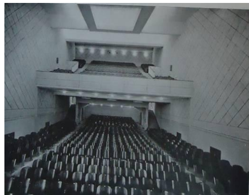
Fig. 4.25 : Le cinéma Le Plaza. Intérieur Revue chantier. Janvier 1939
