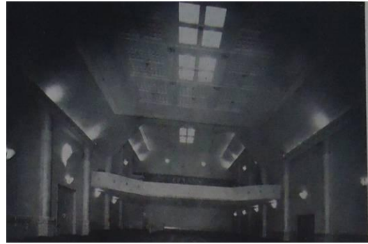
Fig. 3.3 : Balcon et plafond aéré du Rialto Source : revue chantier nord africain, Février 1932
