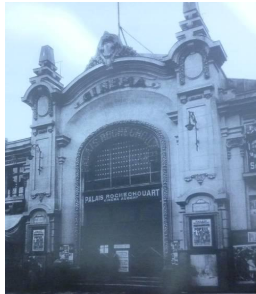
Fig. 1.6 : Palais Rochecouart Paris. Source : S/D Humbert J.M & Pumain Ph., « Le Louxor. Palais du cinéma », éd. A. A. M, Bruxelles, 2013, P. 23.
