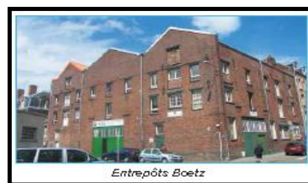
Préservation des entrepôts Boetz Source : Construire le Havre du XXIème siècle
