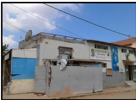
Photo avant de la place d'intervention de centre culturel
