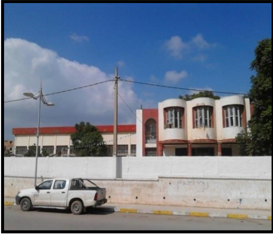
Vue sur le siège de FLN. Photo avant
