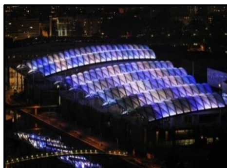
Figure 168: La toiture en ETFE du centre commercial et de loisir de Confluence de Lyon la nuit
