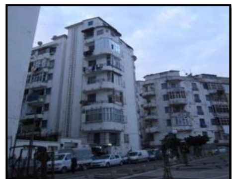
Figure 24 : bâti de type HBM. Source : l'auteurs.
