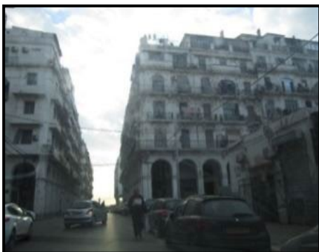
Figure 23 : bâti de type colonial. Source : l'auteurs.
