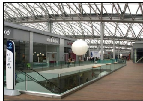
Figure 171 : Vue sur l'atrium du centre commercial et de loisir de Confluence de Lyon. Source : http://bonjour-lyon.fr .
