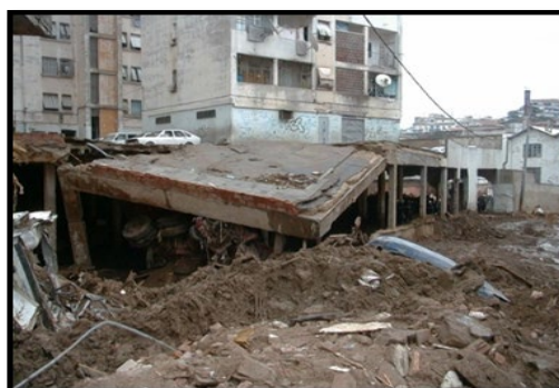
Figure 15 : les dégâts des inondations 2001. Source : mémoire fin d'étude L'EPAU 2018.
