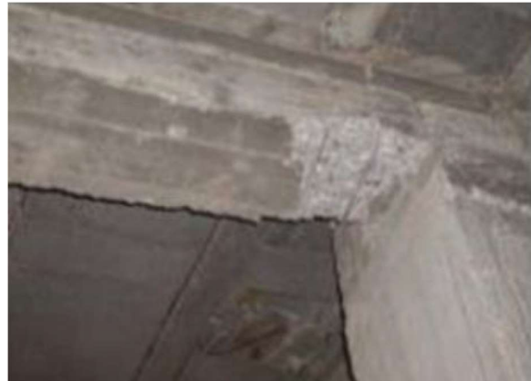
Figure I.23: rotule plastique dans la poutre (Comportement recherché)[18].
