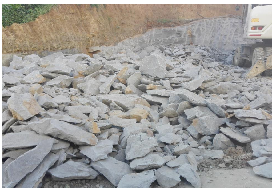
Figure III.8 : Site d'extraction du matériau naturel (marne) à l'état rocheux.
