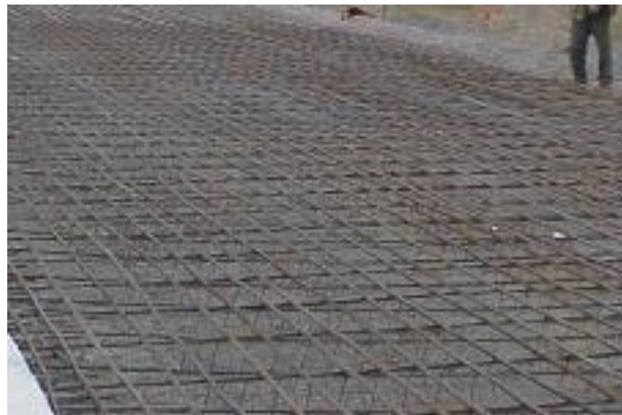
Figure I.12 : Armature filante d'une chaussée en béton armé.
