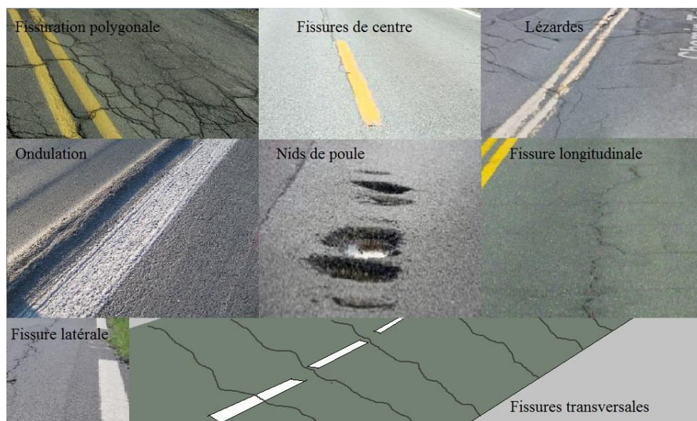
Figure I.13 : Types de dégradations des chaussées.
