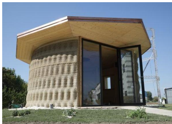
Figure 21 : GAIA : première maison 3D en terre-paille. Italie source : We Demain/ ma maison demain (2018)
