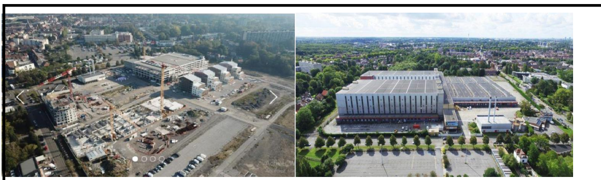
Figure 52 : chantier de la Maillerie Source : Bouygues Bâtiment-Nord-Est 2021
