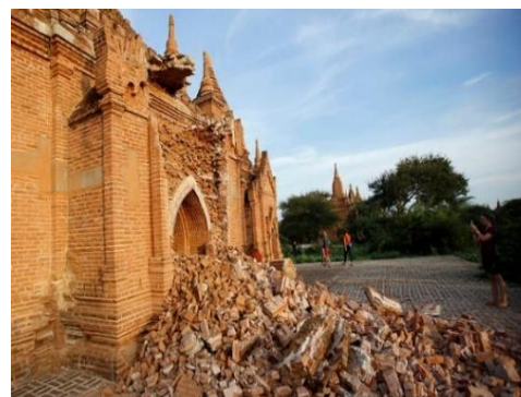
Fig 814 Birmanie : les temples de Bagan endommagés par un séisme
