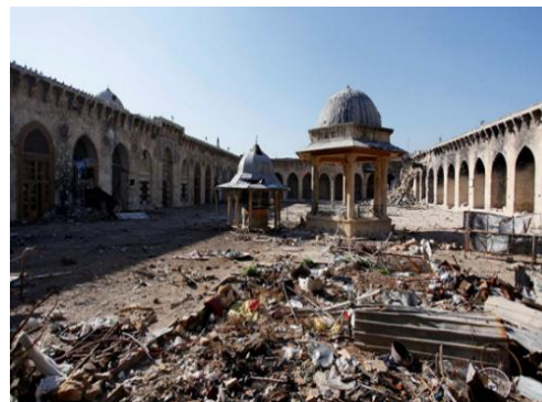
Fig 895 La grande mosquée d'Alep endommagée par la guerre en Syrie. Source : ici.radio-canada.ca
