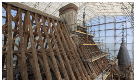
Fig 1910 Rénovation du Château d'Azay-le-Rivier
