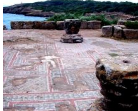
Fig 82 état de dégradation des vestiges Source : PPMVSA
