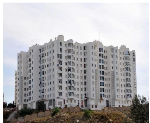
Fig 4080 logement ADL Source : www.huffpostmaghreb.com
