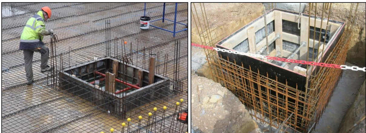
Figure 93: Fondation des ascenseurs source : http://imagesdubtp.iutrs.unistra.fr/index.php?/tags/7331-fosse_ascenseur
