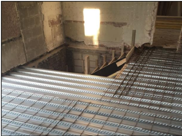
Figure 94: Réalisation d'un plancher collaborant en rénovation et création d'un escalier en béton armé Source : http://interext.fr/2016/10/travaux-de-gros-oeuvre/
