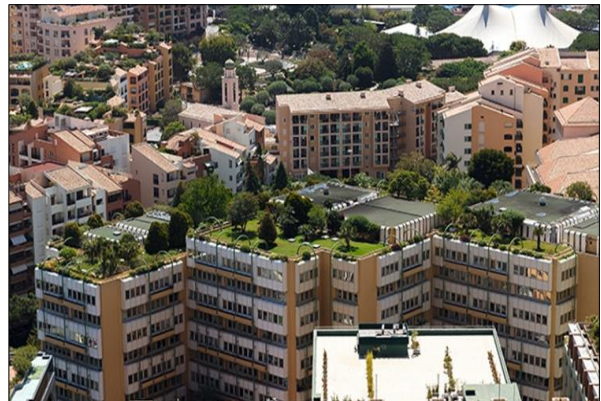
Figure 63 : le nouveau jardin municipal de : la toiture végétalisée Source : https://www.prestigerootinglv.com/wp-content/uploads/2016/08/bigstock-Monaco-building-roofs-86913041.jpg
