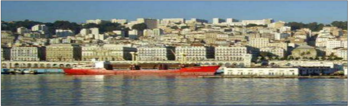
Figure 4: Vue sur le front de mer Source : Parque EXPO, 2010
