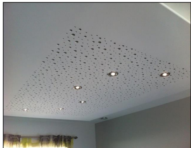
Figure 105: Exemple des faux plafond en placo plâtre
