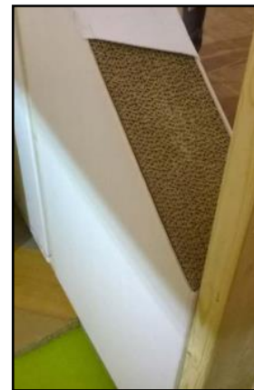
Figure 73 : un mur en carton Source : https://dumas.ccsd.cnrs.fr/dumas-01959175
