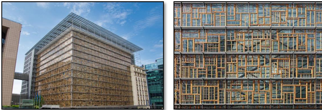
Figure 62 : façades en patchwork en bois récupérés
