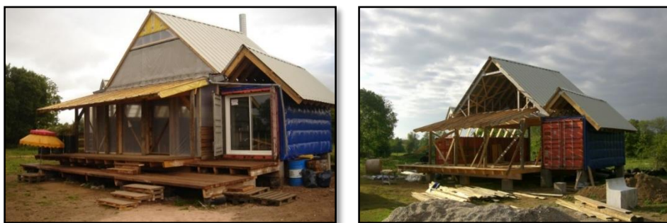
Figure 60 : façades de la construction d'Argentan (France), avec les matériaux réemployés et réutilisés Source : https://www.ouest-france.fr/normandie/argentan-61200/aux-jardins-la-recup-des-architectes-tient-bon-5043755
