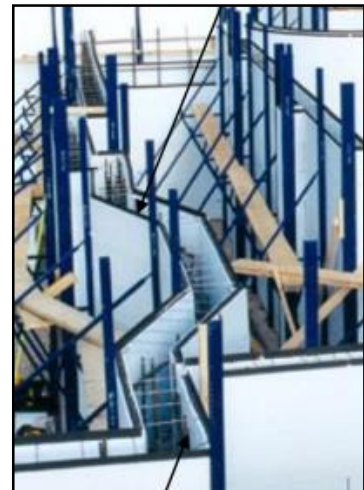
Figure 68 : Coffrage en plastique recyclé à Thala Atman, Tizi -Ouzou.
