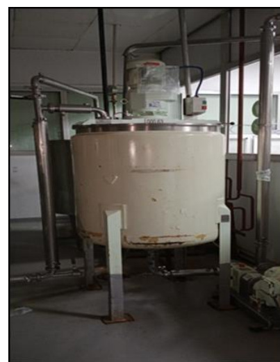
Figure 6 : cuve de stockage
