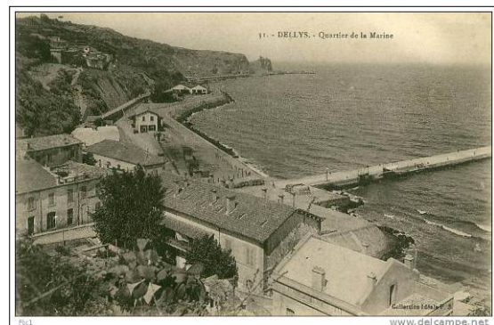
Fig24 : Vue sur la jetée. Source : Google image.
