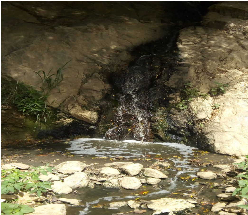
Figure 15. Eaux usées au niveau de Harouza.
